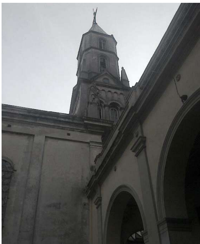
Foto 2. Autor Fabrizio Martínez. Detalle de la torre de la iglesia, vista desde el sector izquierdo, patio interior masculino, Hospital Vilardebó (2016).
